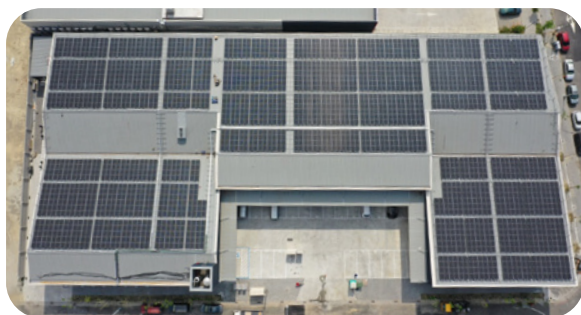
• 南方倉儲物流中心 屋頂建置太陽能發電系統
