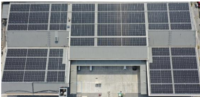
● 南方倉儲物流中心屋頂建置太陽能發電系統
